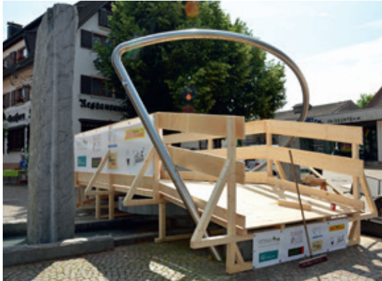
Eine großartige Zimmermannsleistung war die Brücke mit Sprung über den Zeitensegelbrunnen.
